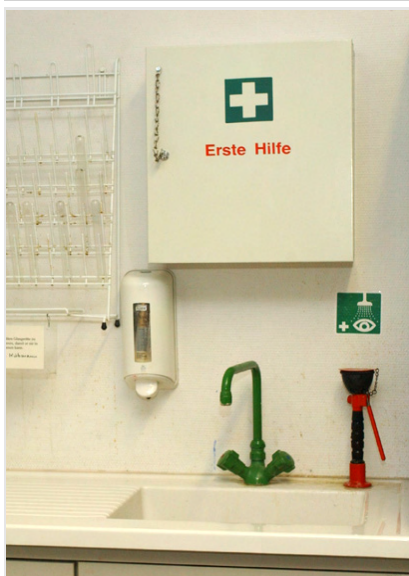
Bilder: Verbandkasten in Sporthalle, Werkstätten, Labor
